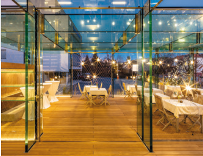
Glasbalken für tragende Funktion
