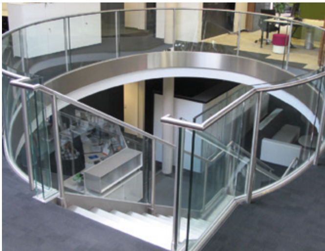
Einseitig eingespannte Glasbrüstung
